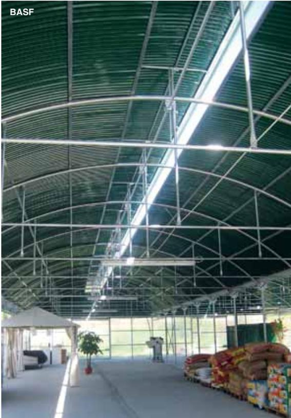
degradarse y deformarse en las regiones que están más expuestas al sol. La empresa trabajó en estrecho contacto con Basf para la puesta a punto de una mezcla oscura de PVC y copolímero SAN (Luran HH 120), cuya temperatura de ablandamiento Vicat (120°C) es
